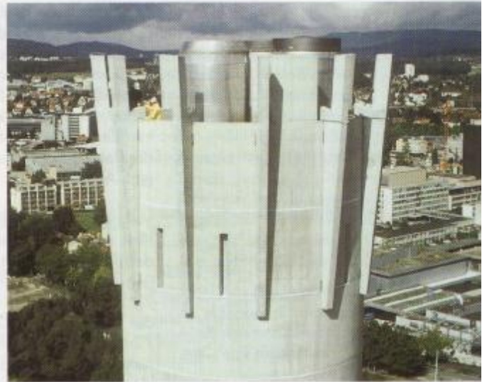
Abb. 9: Kaminhut einer Müllverbrennungsanlage
