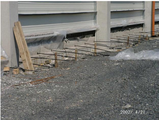
**Bild 6** Vorgespannte WHG-Hallenfläche mit einer Plattenlänge  $l = 65$  m bei einem Spanngliedabstand  $e = 50$  cm. Die Spannglieder mit Hüllrohr ragen im Bauzustand zum Aufbringen der Vorspannung aus der Platte heraus.
