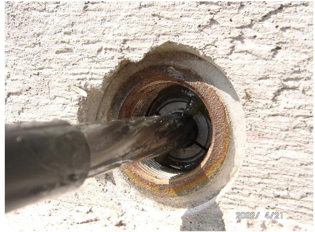
**Bild 7** Detail eines Spannglieds am Spannanker mit gefettetem Hüllrohr und Ankerkeilen.
